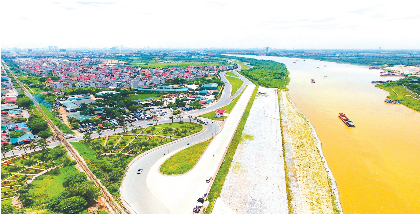
Đoạn đê kè Thanh Am - Tỉnh Quang (quận Long Biên).
